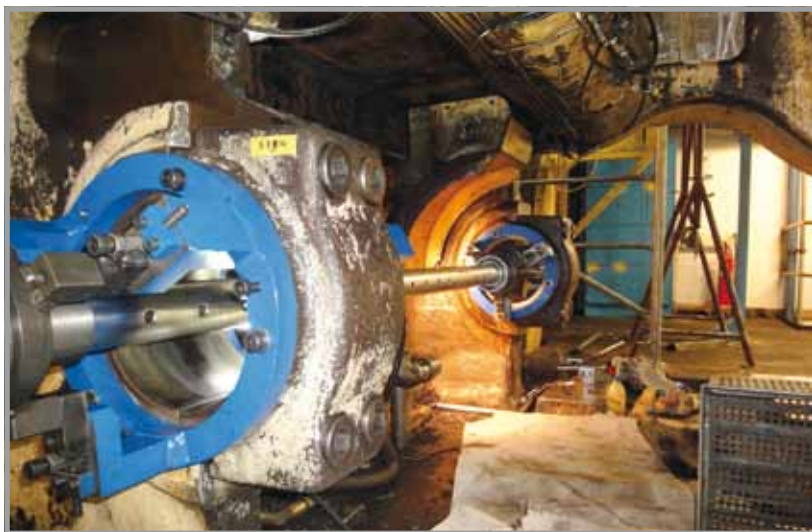
上：マシン本体の修理作業
