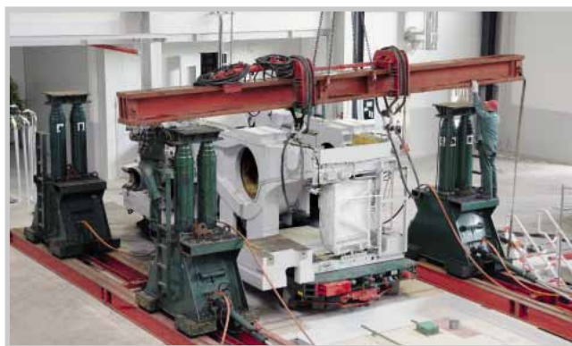
Für die letzten Meter benötigt es hochkonzentriertes Arbeiten, um die Maschine an der korrekten Position abzusetzen. So ist auch die Ausrichtung der Nivellier- und Dämpfungselemente durch den Hatebur Monteur (Fotos in der Reihenfolge ab links oben) von grosser Wichtigkeit.
