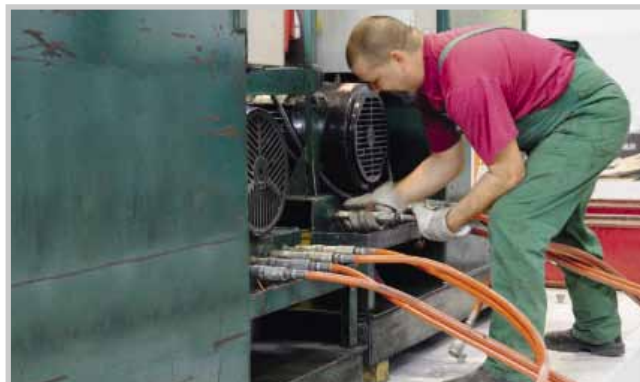
Auf dem exakt ausgerichteten Schienensystem wird die Maschine in ihre Endposition gezogen.
