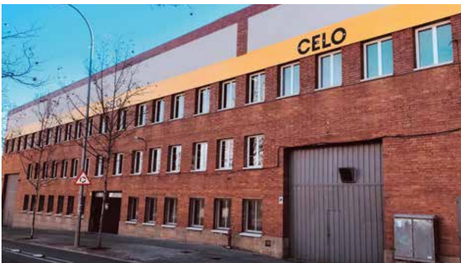
CELO plant in Castellar del Vallès.
