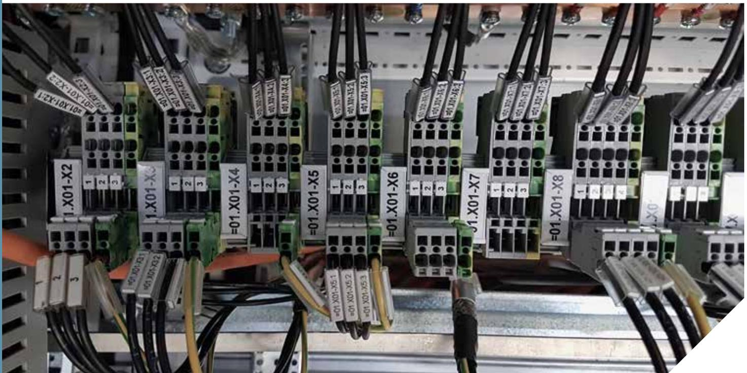
↑ Zur korrekten Identifizierung aller Anschlüsse müssen diese mit eindeutigen Kennzeichnungen versehen werden.
