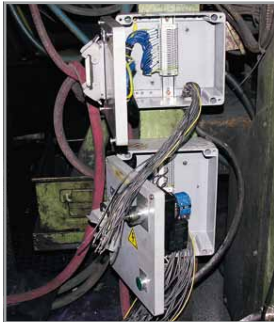
Installation verschiedener neuer Klemmenkästen inkl. Sicherheitssystem.
