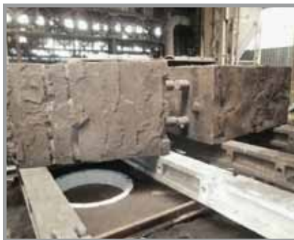
Die vorbereitete Form in der Grube.
